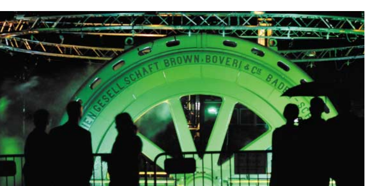
L'usine de production de chaleur et d'électricité à Birsfelden
