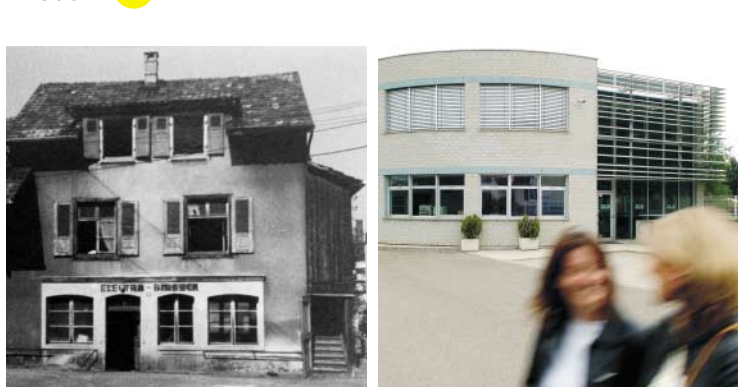
L'usine de production de chaleur et d'électricité à Birsfelden
