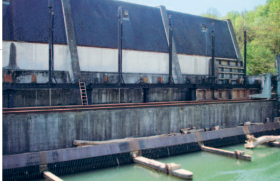
Une des centrales hydroélectriques appartenant à la nouvelle société Birseck Hydro: Trébas-les-Bains sur le Tarn.
